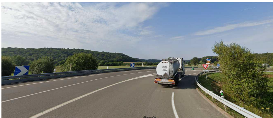
Figure 2 – vue de la section à aménager – source : dossier
