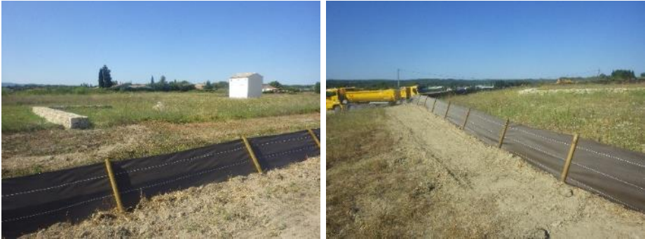
Schéma de principe et exemple de clôtures semi-perméables à la faune (source : Acer campestre)
