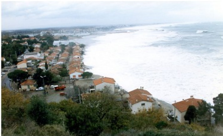
Plage du Racou à Argeles sur Mer lors de la tempête de décembre 1997 (Photo DRE)
