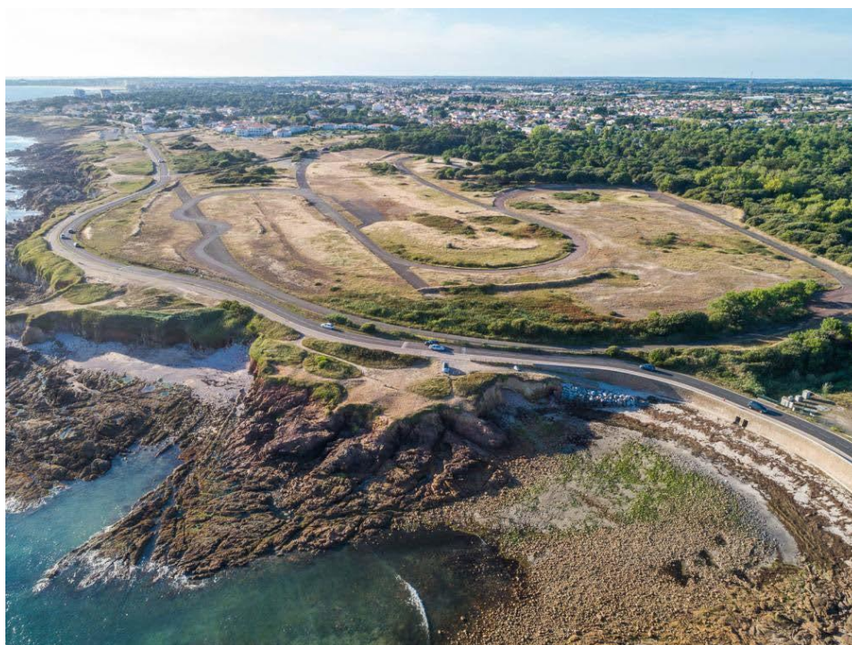
Figure 5 : Vue aérienne de l'ancien circuit. On distingue également deux zones de vulnérabilité de la route du littoral, dont l'une, à droite, est protégée par des enrochements- (source : dossier)
