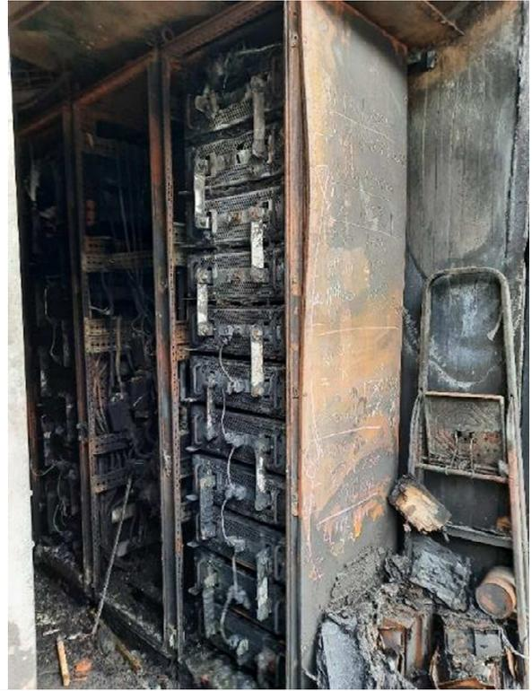
Photo 7 ter : vue d'un rack de modules de condensateurs souillés par la suie.
