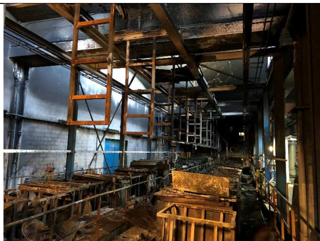
Photo 1 : Vue des chaines acier / alliages légers et du mur coupe-feu sur la gauche
