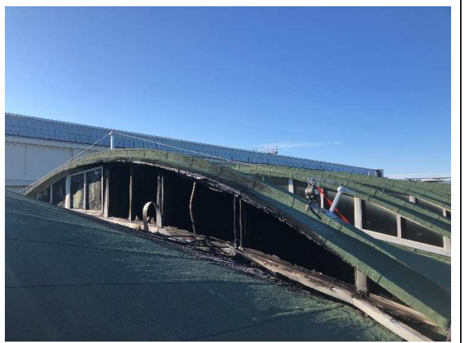
Photo 9 : Vue d'une baie vitrée en façade ayant résisté à la chaleur
