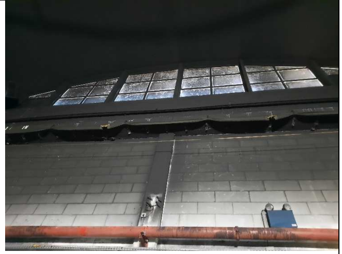
Photo 9 : Vue d'une baie vitrée en façade ayant résisté à la chaleur
