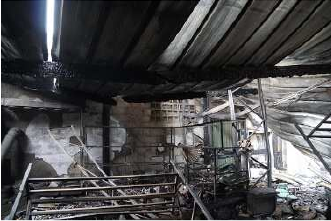
Photo 7 : importants dégâts relevés côté vernissage
