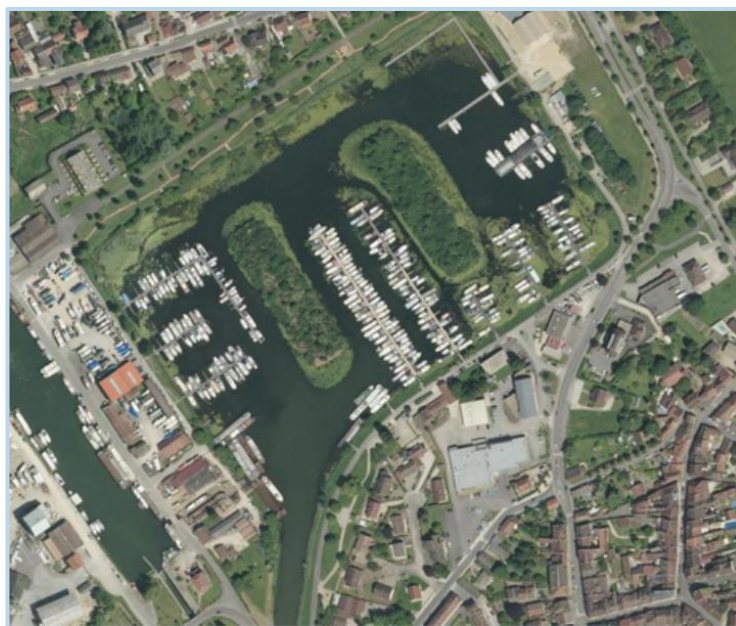
Figure 53 : vue aérienne de la gare de Saint-Jean-de-Losne
