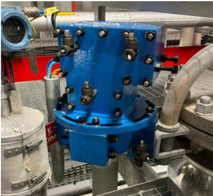
Figure n°6 : Radar après la pose d'un système d'obturation de fuite (crédit EMCF)
