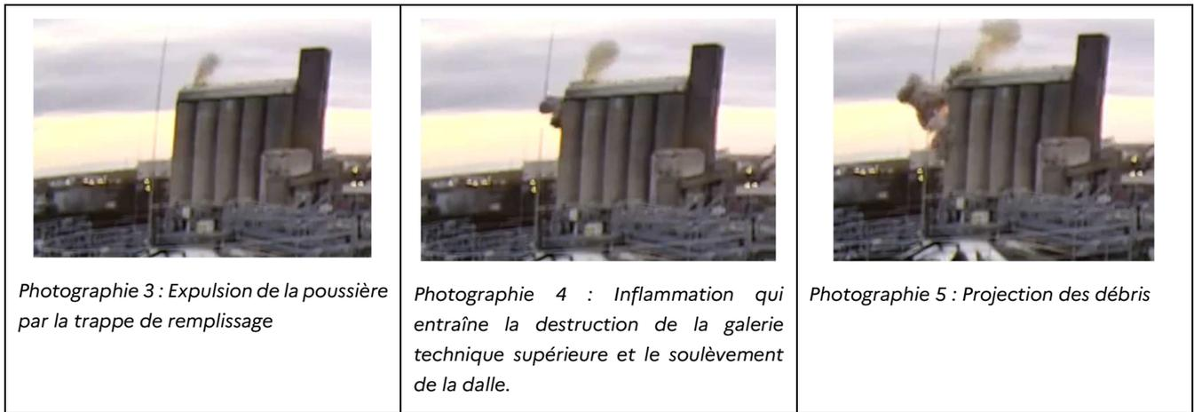
L'explosion est donc la conséquence de l'inflammation d'un mélange de poussières dû à un auto-échauffement et, en moindre proportion, de gaz de pyrolyse dans la cellule 20, rendu possible par la présence en quantité importante de pellets de luzerne et de poussières sur les parois de la cellule.
