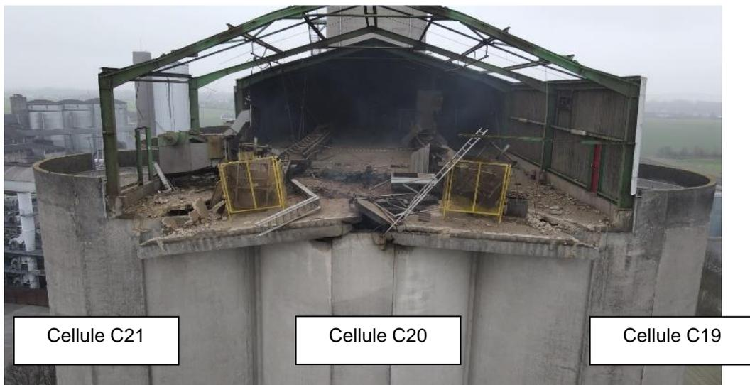
Figure 9 : Prise de vue du sommet du silo après l'accident du 6 janvier 2023 et le retrait des éléments de bardages de la galerie sur cellules
