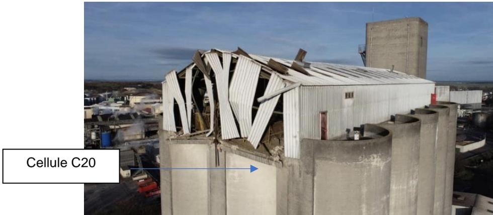
Figure 3 : Prise de vue du sommet du silo après l'accident du 6 janvier 2023 et avant le retrait des éléments de bardages de la galerie sur cellules [photo transmise par le BEA-RI]
