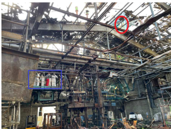
Figure 9 : Position d'une tête de l'installation d'extinction automatique à eau dans l'atelier (entourée en rouge) et taille humaine (rectangle bleu)
