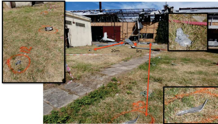
Figure 7 : Projection de fragments au Sud du bâtiment
