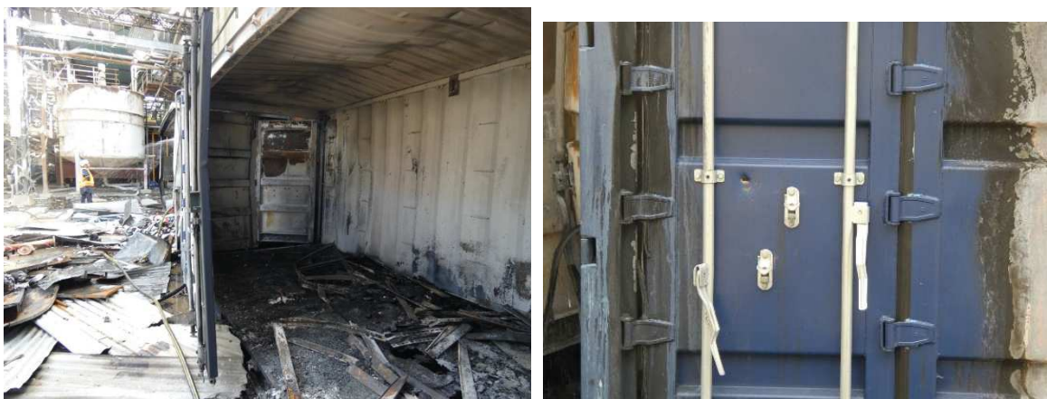
Figure 19 : Dommages subis par le container
