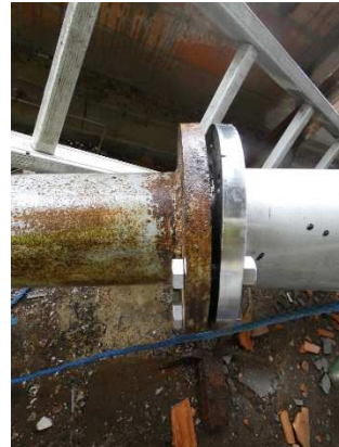
Photos 3 et 4 : Vue rapprochée des 2 tuyauteries en cours de raccordement avec les boulons manquants
