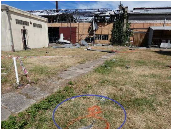
Photo 5 : Projectile en acier retrouvé à plus de 30 mètres du bâtiment
