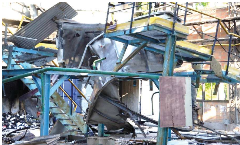
Figure 18 : Dommages subis par la cuve non raccordée
