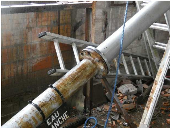
Photos 3 et 4 : Vue rapprochée des 2 tuyauteries en cours de raccordement avec les boulons manquants
