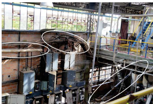
Figure 12 : Principaux dégâts liés aux effets de surpression ou de projection de fragments observés sur les équipements du process – partie Est du bâtiment - vue du dessus
