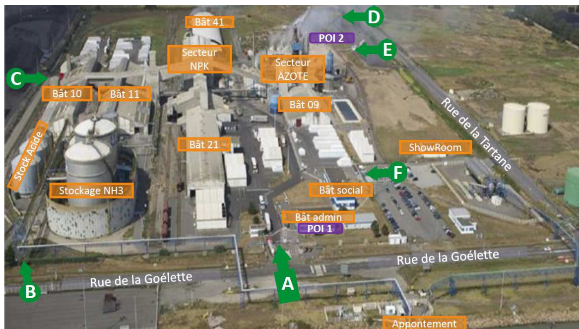
Figure 3 : Vue du site de YARA (Crédit SDIS44)
