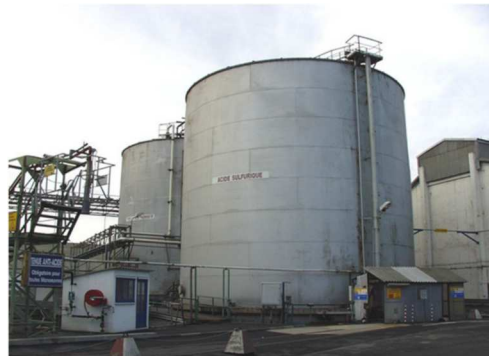
Photo 4 : Réservoirs d'acide sulfurique
