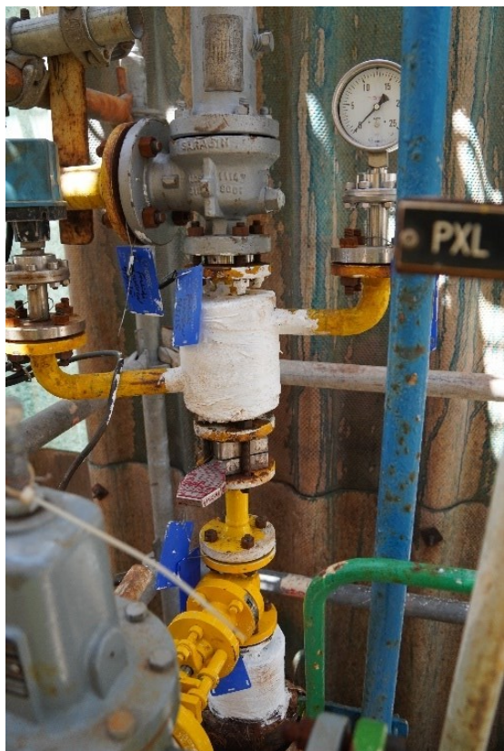
Photographie 2 : Photo du trident remonté après l'accident
