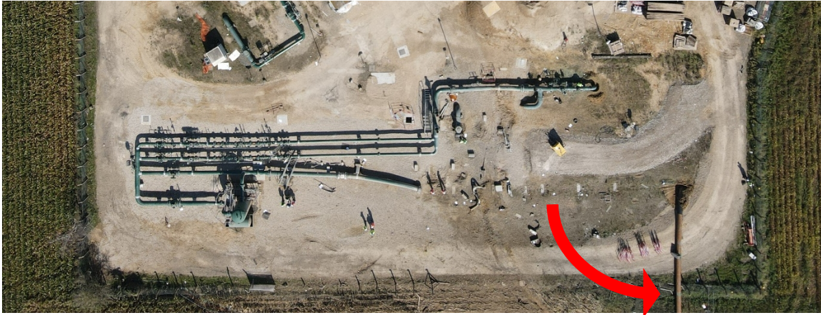
Figure 5 : Vue aérienne du pôle Etrez après l'explosion. La canalisation entre l'entrée du site et la gare racleur a pivoté de 90° (flèche rouge). La lyre n'est plus visible : elle s'est rompue en plusieurs points et a été projetée.
