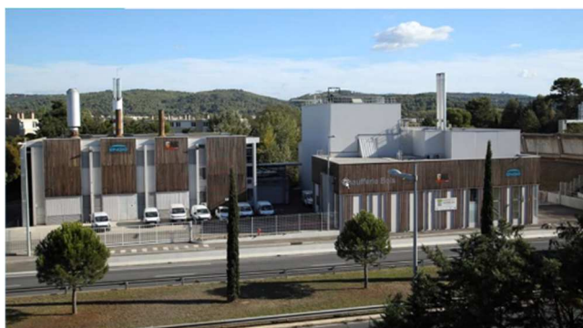
Photographie 1 : Vue du bâtiment à droite abritant les 2 chaudières biomasse du site APEE
