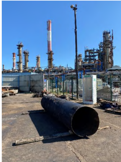
Figure 7 : tube identifié comme à l'origine de la fuite
