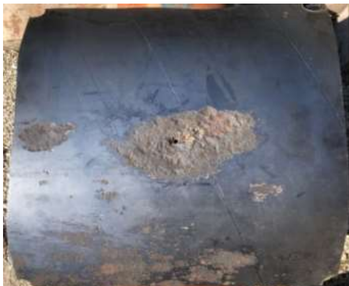
Figure 12 : P1 après enlèvement du brai et nettoyage
