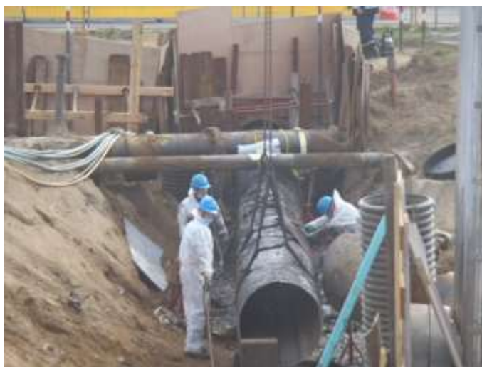
Figure 8 : Vue de l'extraction des tronçons de pipeline
