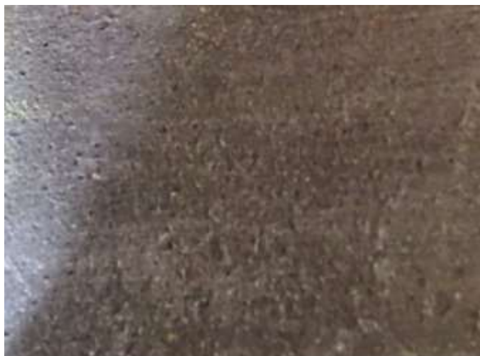
Figure 11 : Vue de la paroi intérieure (T9)
