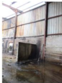
Figure 10 : Séparation en béton entre le foin et les vaches
