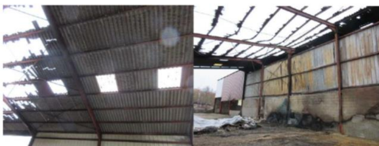
Figure 6 : toiture au-dessus du côté du stockage d'engrais
