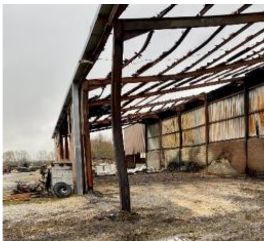
Figure 3 : Photo du hangar le 8/12/2020
