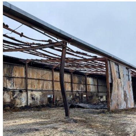
Figures 11 et 12 : Photo du hangar permettant de visualiser la déformation de la structure métallique
