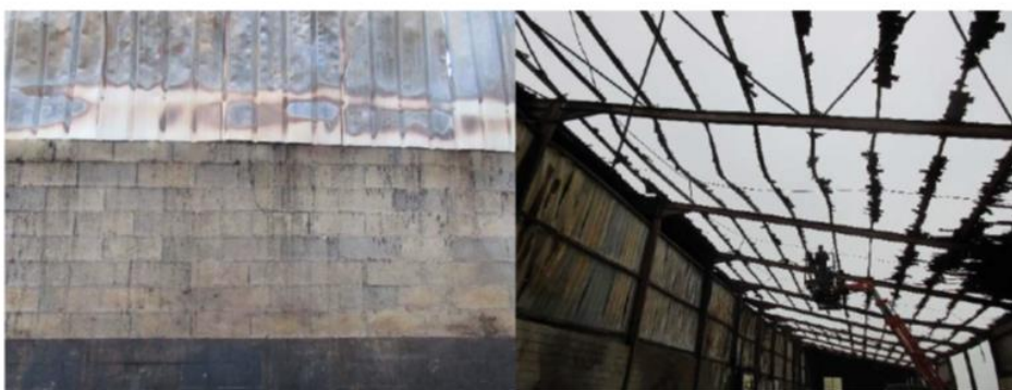
Figure 5 : vue arrière du centre du hangar et toiture à l'opposé du stockage d'engrais
