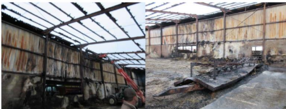
Figure 4 : Vue centre du hangar
