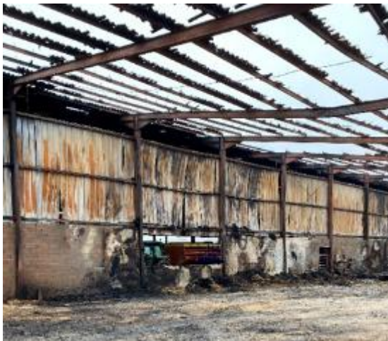
Figures 11 et 12 : Photo du hangar permettant de visualiser la déformation de la structure métallique
