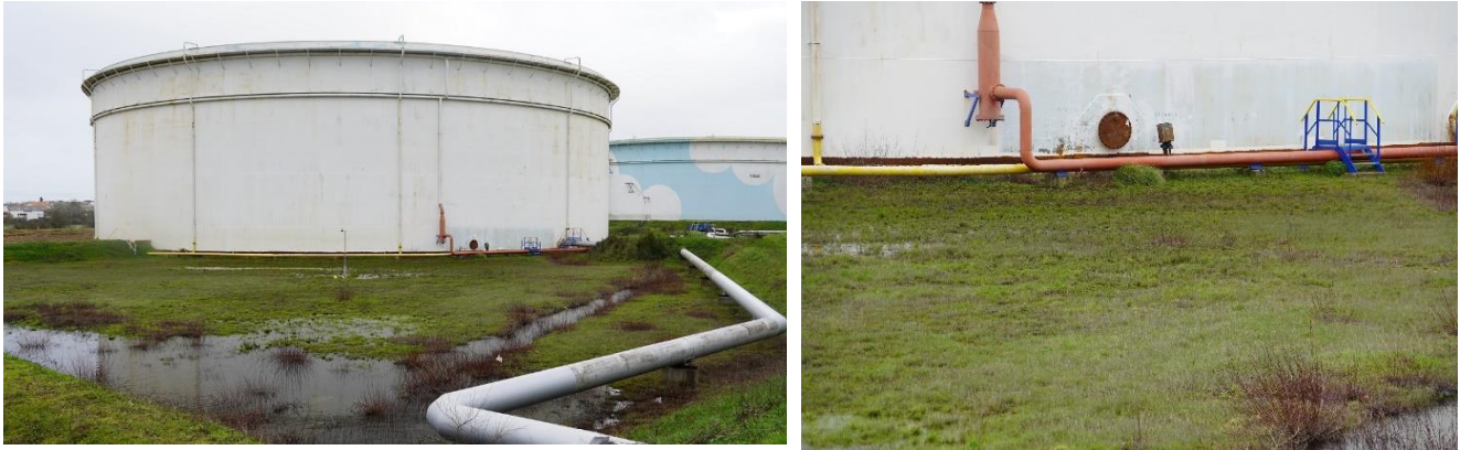
Figures n°10 et n°11 : état de surface de la cuvette de rétention
