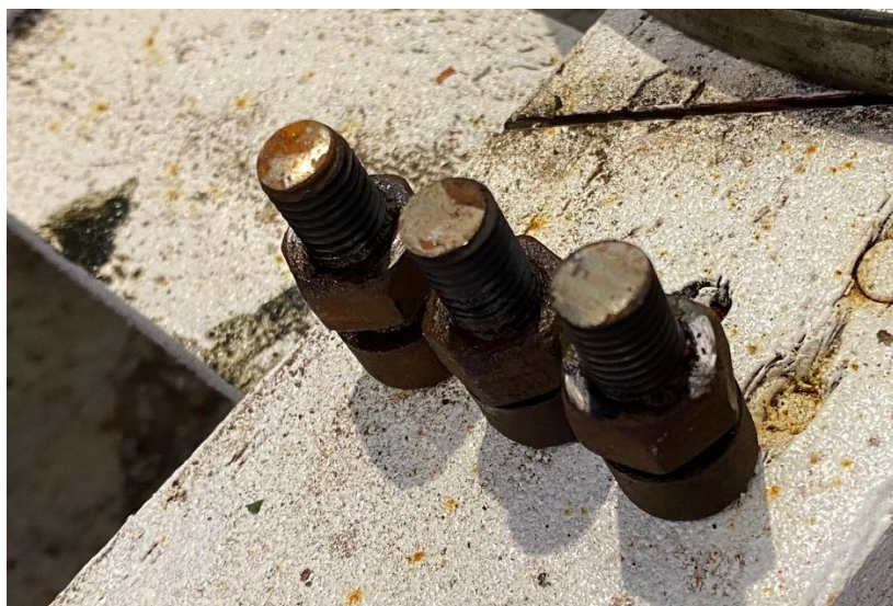
Figure n°8 : vis de fixation de la coupole
