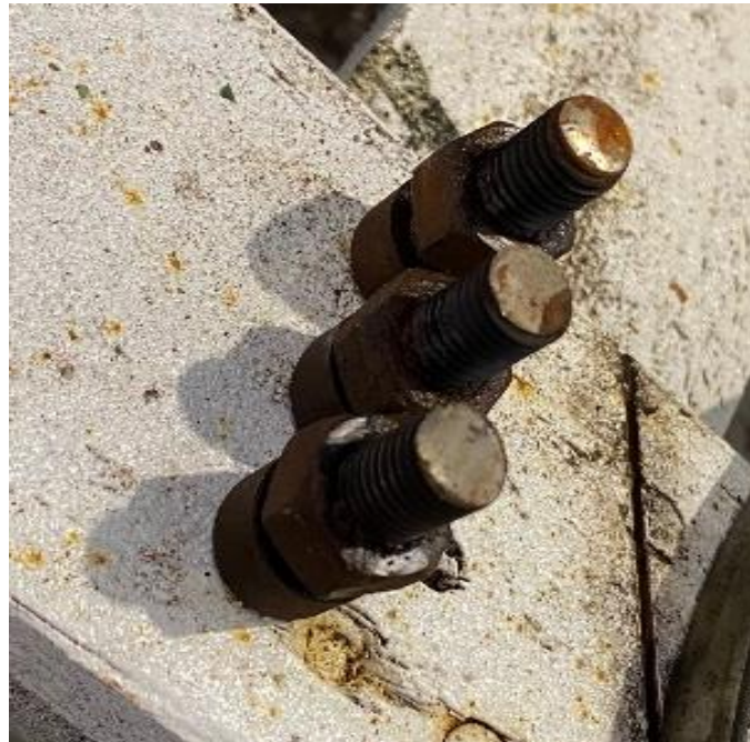
Figure 19 : vis à bouts plats
