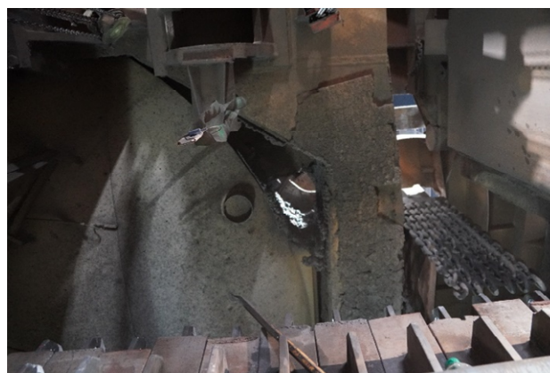
Photographie 9 : Vue du trou depuis le niveau inférieur sous le four.
