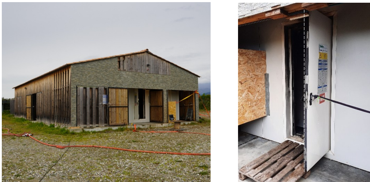
Photographie 6 : Photographies du bâtiment qui abrite les BESS (en haut à gauche : vue aérienne du bâtiment, en haut droite vue ¾ arrière du bâtiment ; en bas à gauche, vue ¾ avant du bâtiment, en bas à droite vue de la porte arrière légèrement cintrée)
