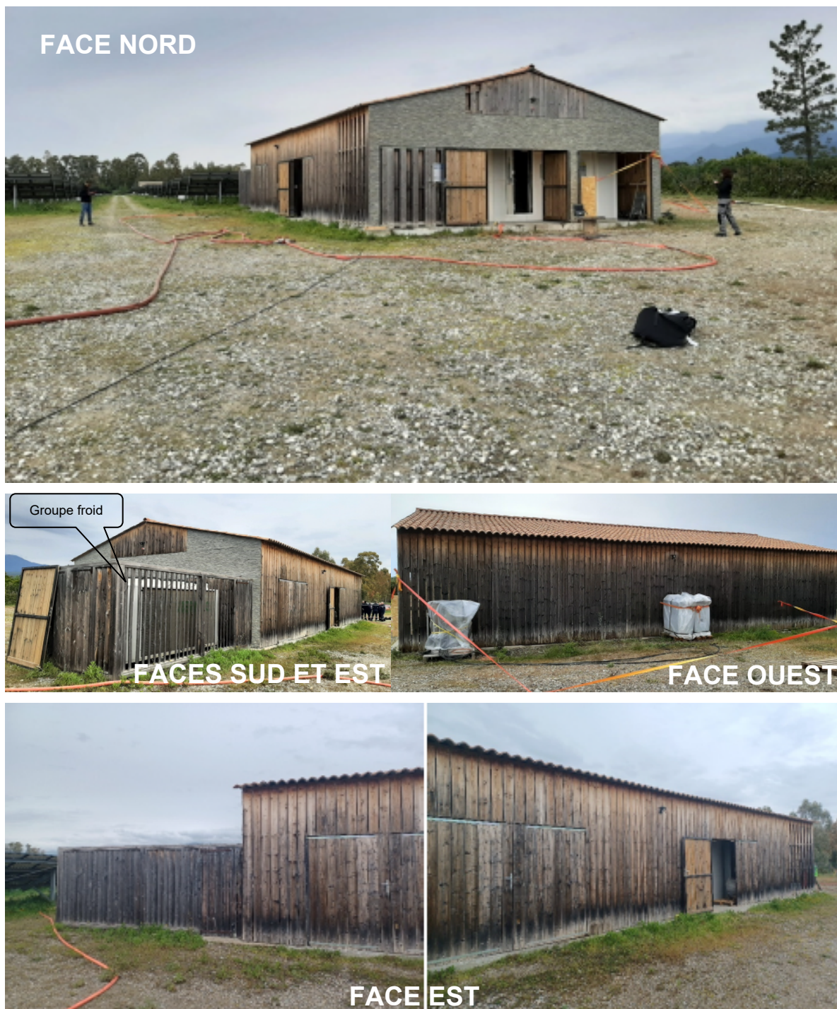
Figure 2: vues du bâtiment abritant les conteneurs de stockage d'énergie
