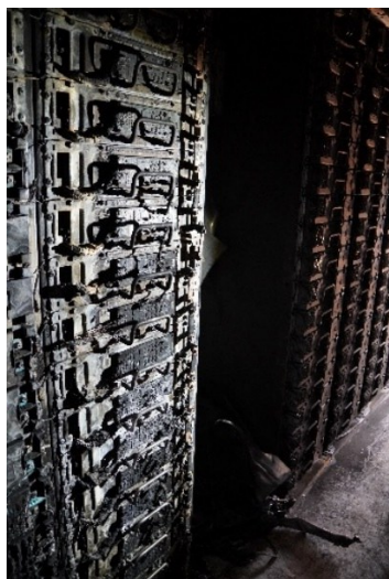
Photographie 8 : Vue générale du rack 1 du BSC3. On constate une combustion progressive des gaines isolantes des connexions électriques en façade des modules. La gaine isolante du module 10 a totalement brûlé (repère 2). On voit en revanche que l'isolant est moins dégradé au fur et à mesure que l'on s'éloigne de ce module (repères 1 et 1 bis). Ce gradient de dégradations montre que l'incendie n'a pas affecté le rack de manière égale sur toute la hauteur, l'intensité étant plus forte au niveau du module 10 (repères 2 et 3).
