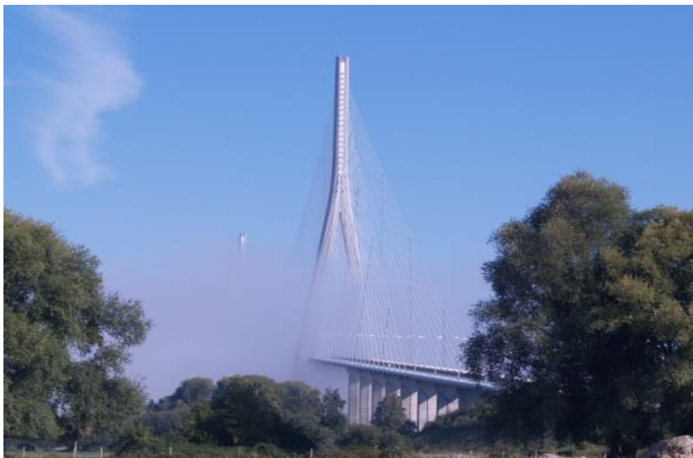
Le Pont de Normandie
