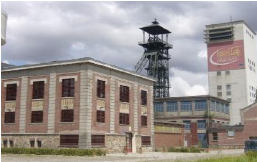
Crédit photo : DREAL Haut-de-France : chevalement bassin minier
