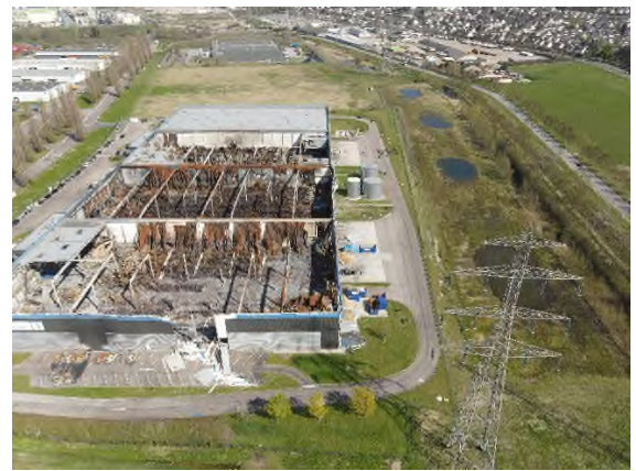
Photographie 38 : Vue aérienne de l'entrepôt et à droite la présence de la ligne à haute tension.
