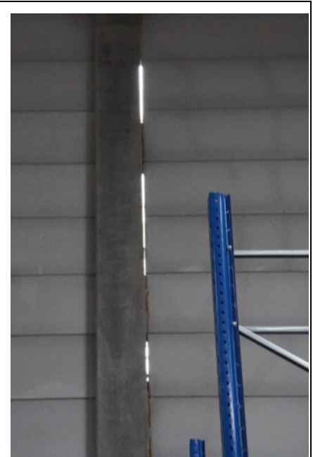
Photographie 20 : liaison poteau-mur préfabriqué.
