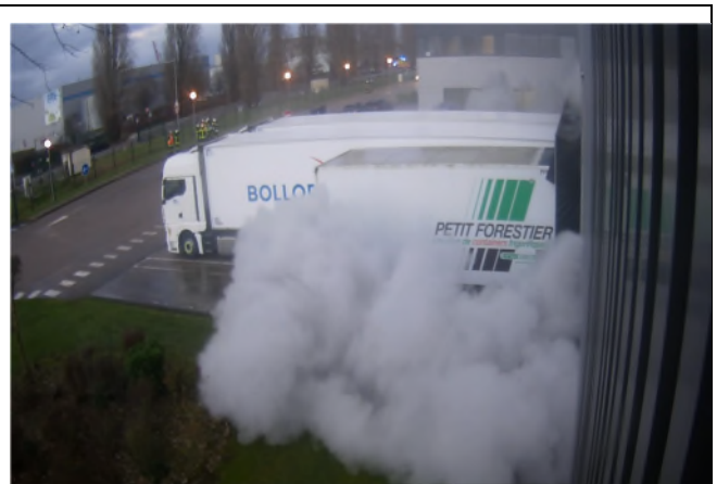
Photographie 22 : Émission de fumées en façade nord.
