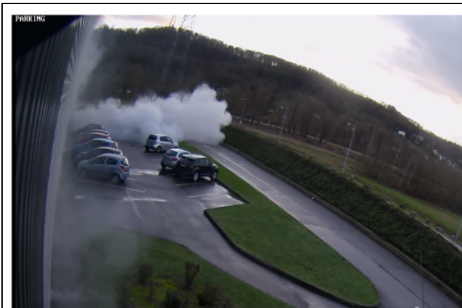
Photographie 21 : Émission de fumées consécutives à une explosion à l'intérieur de la cellule 1 (Façade ouest).
