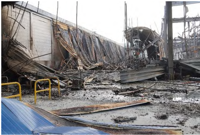
Photographie 4 : Vue du mur intercellules 1-2 avec une partie de la couverture encore accrochée.
