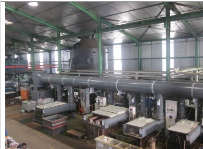
Photo 13: Vue de la zone de production (point de vue G) avant l'incendie. On y aperçoit le système d'aspiration des vapeurs constitués de tubes et au second plan l'imposante tour de lavage en PEHD.
