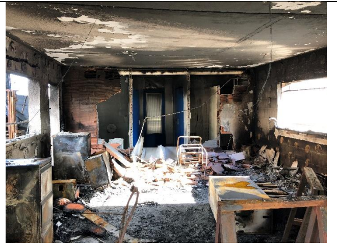
Photo 12 : Photo des bureaux ( Vue D )
