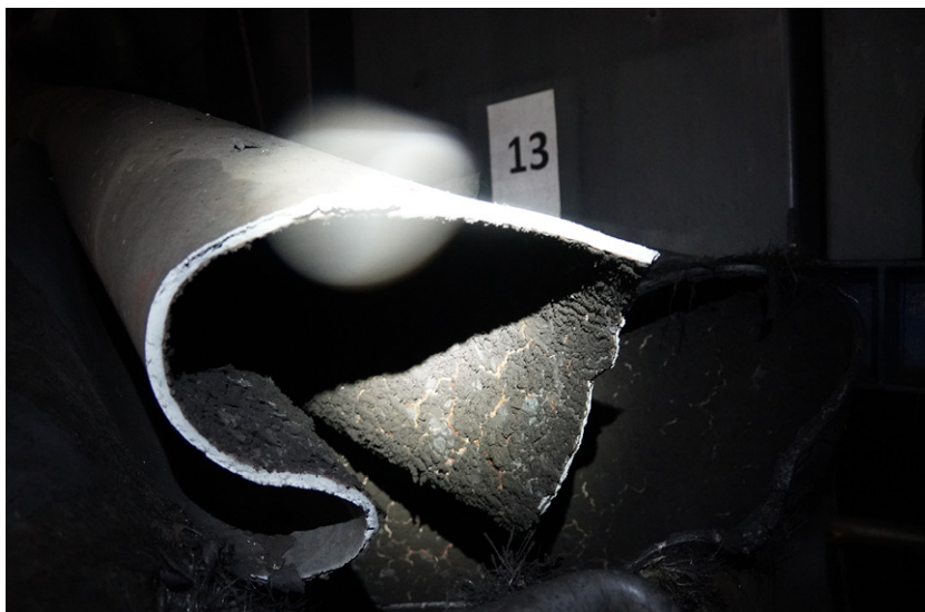
Émissaire de collecte des vapeurs de bains carbonisés et déformé (Aubert et Duval - Pamiers- 09).
