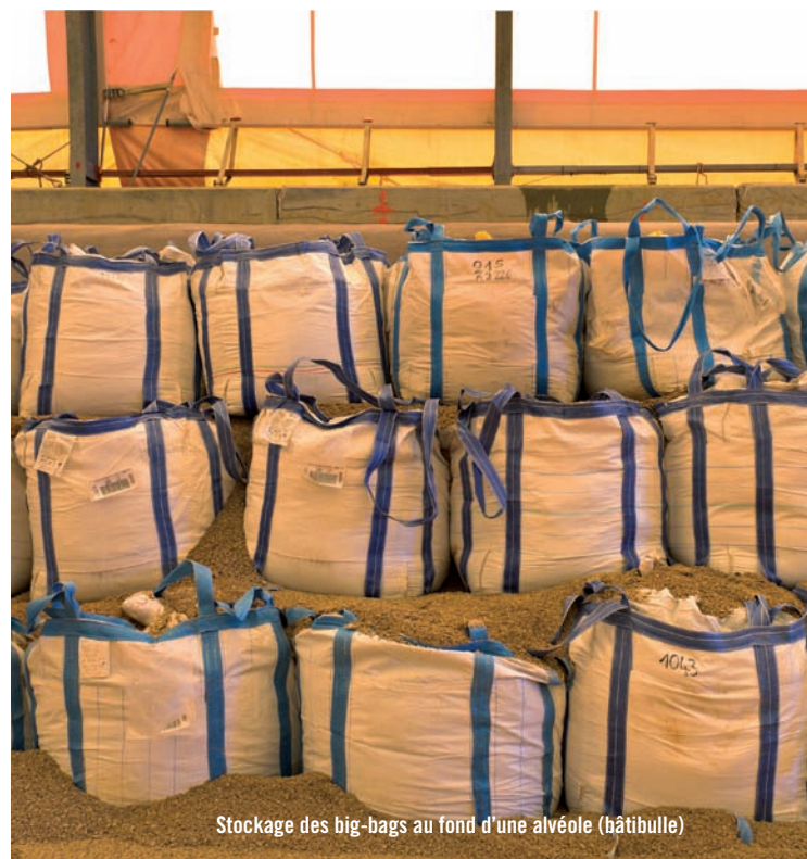
Alvéoles de stockage du CSFMA
