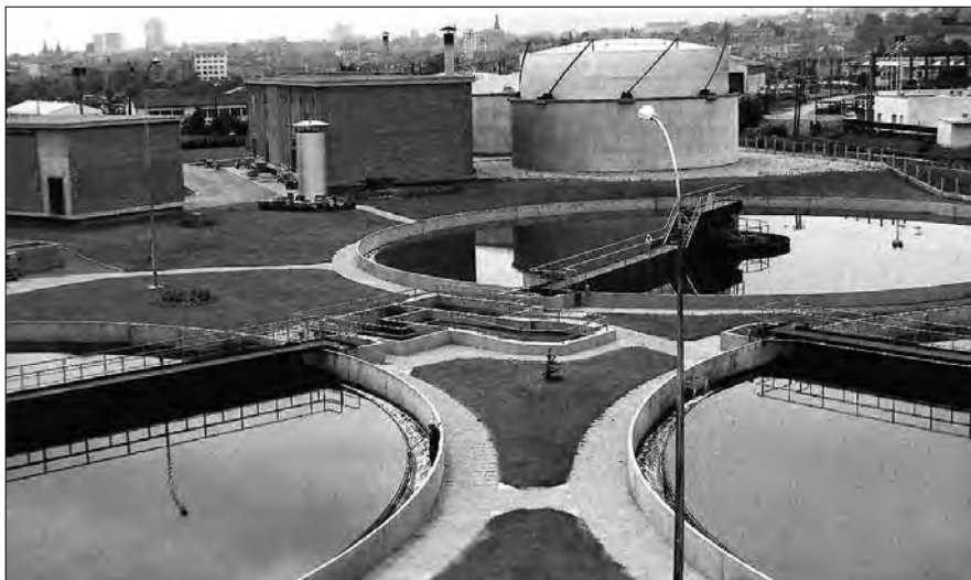
Station d'épuration à Nancy en 1975 © Agence de l'eau Rhin-Meuse
