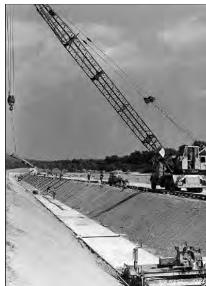
Chantier du canal maître réalisé en 1967 par la Société du Canal de Provence et qui sera mis en service en 1969 © SCP
