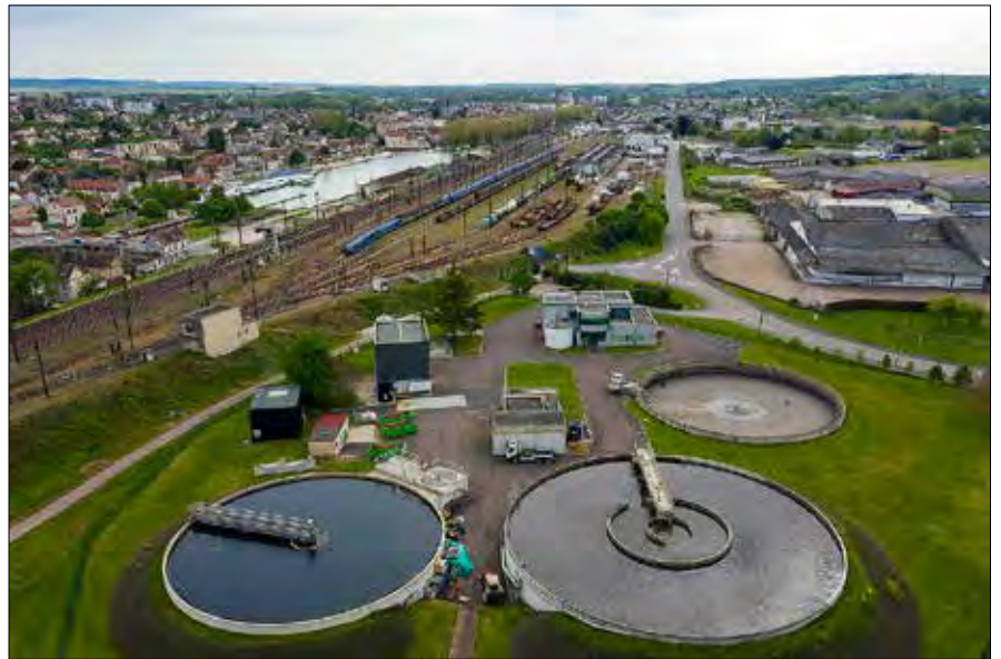
Station d'épuration de Migennes dans l'Yonne © Terra / H.-M. Duclos. La Directive Eaux Résiduaires Urbaines (DERU) de 1991 a obligé la France à moderniser un grand nombre de stations d'épuration, et pas seulement des petites, et c'est ainsi la partie eaux usées de la facture d'eau qui est responsable de l'augmentation du prix de l'eau dans les années 1990.
