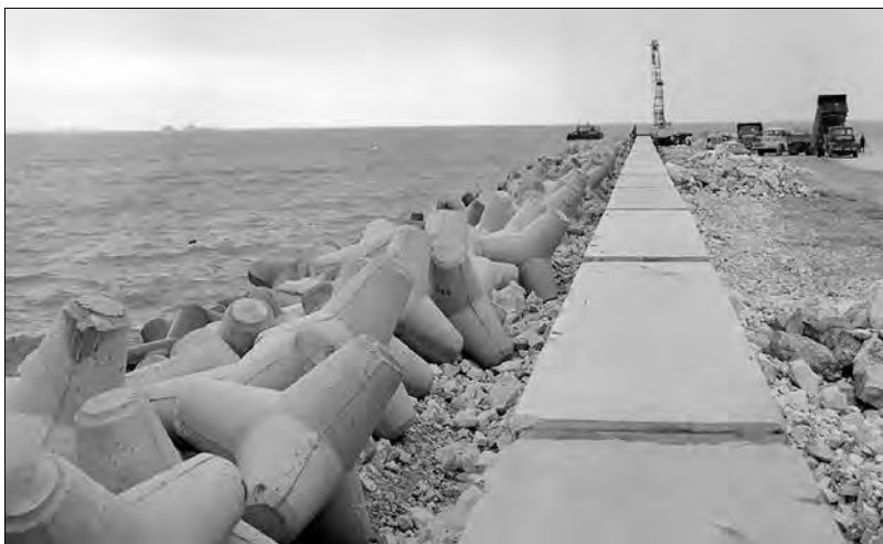
Digue de protection de l'avant-port de Fos © Terra / H. Salessa
