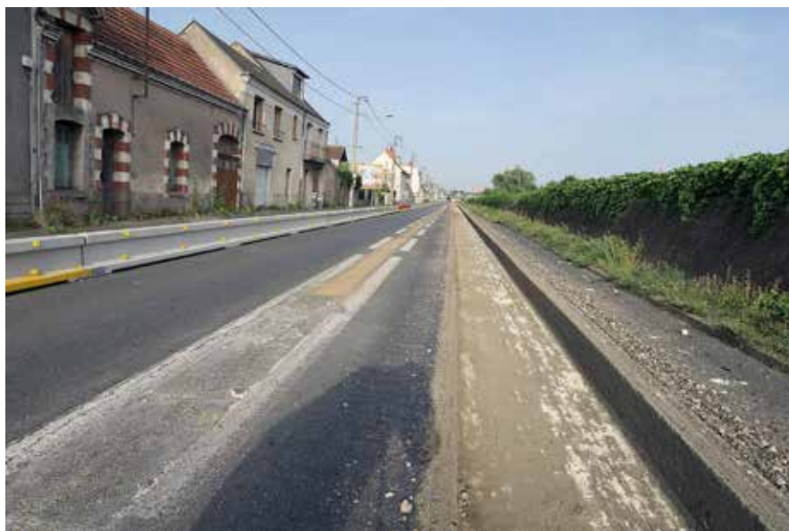
Digue à proximité de l'entrée ouest de la ville de Saint-Pierre-des-Corps
