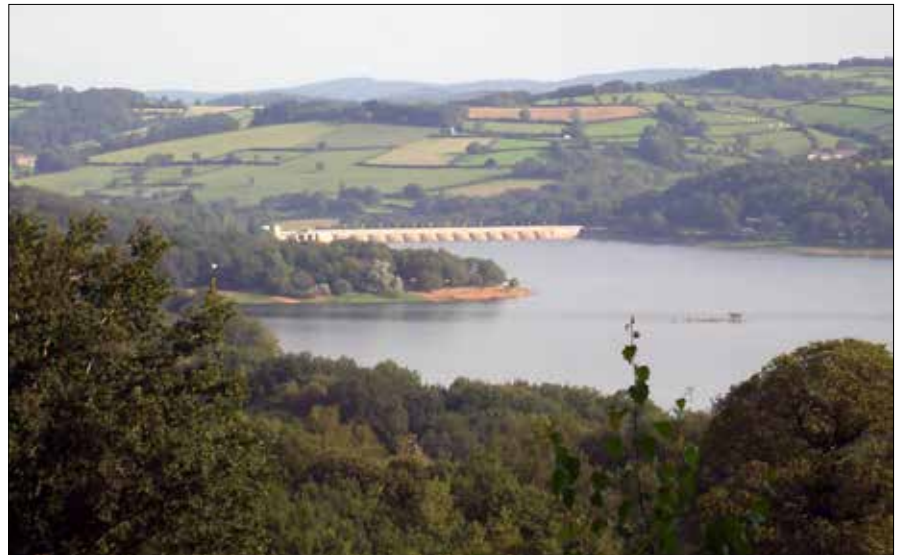
Le barrage et le lac de Pannecière (EPTB Seine Grands Lacs, 2008) © Benchaum/Wikimedia Commons
