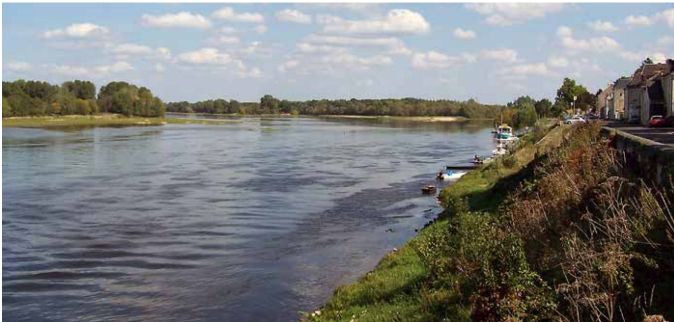
Levée de la Loire au niveau de la confluence avec la Vienne (2011) © LPLT/Wikimedia Commons
