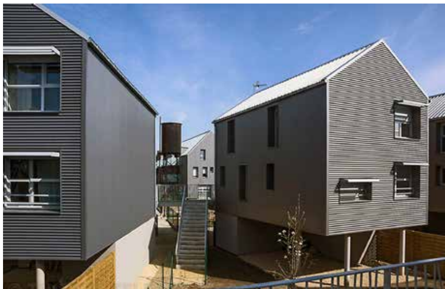
Nouvel'R, opérations de 80 logements à Saint-Pierre-des-Corps (arch. : AAG, 2014)
