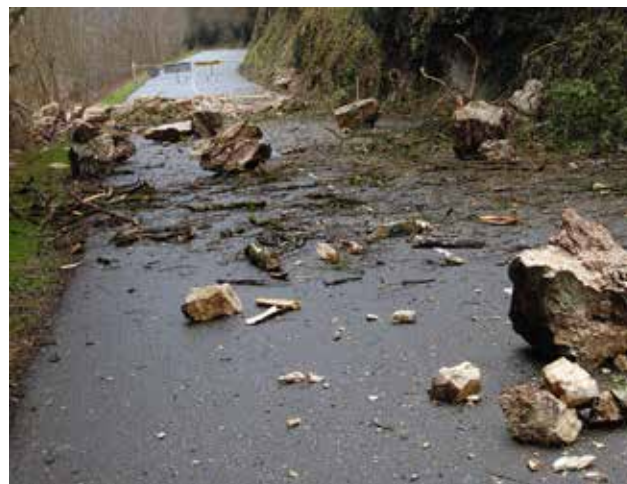
Chute de pierres et de blocs (Isère, 2007) © IRMA/S. Gominet
