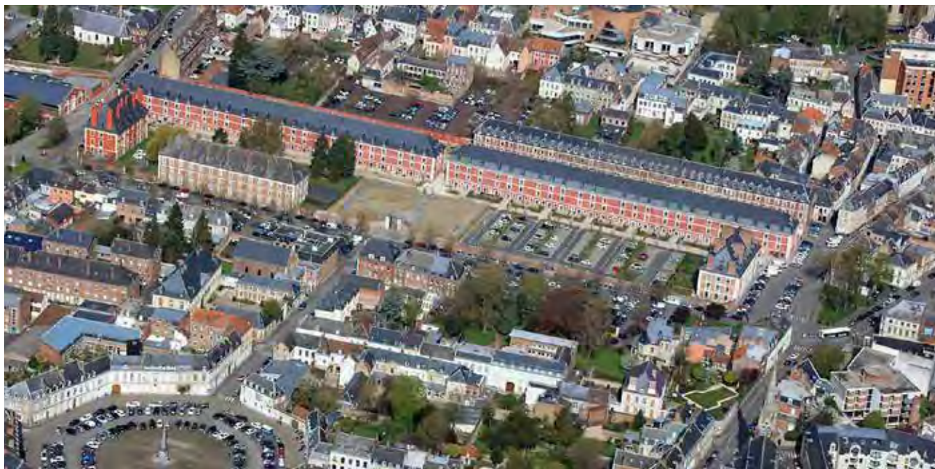
La caserne Schramm à Arras, reconverte en logements © communauté urbaine d'Arras / Philippe Frutier
