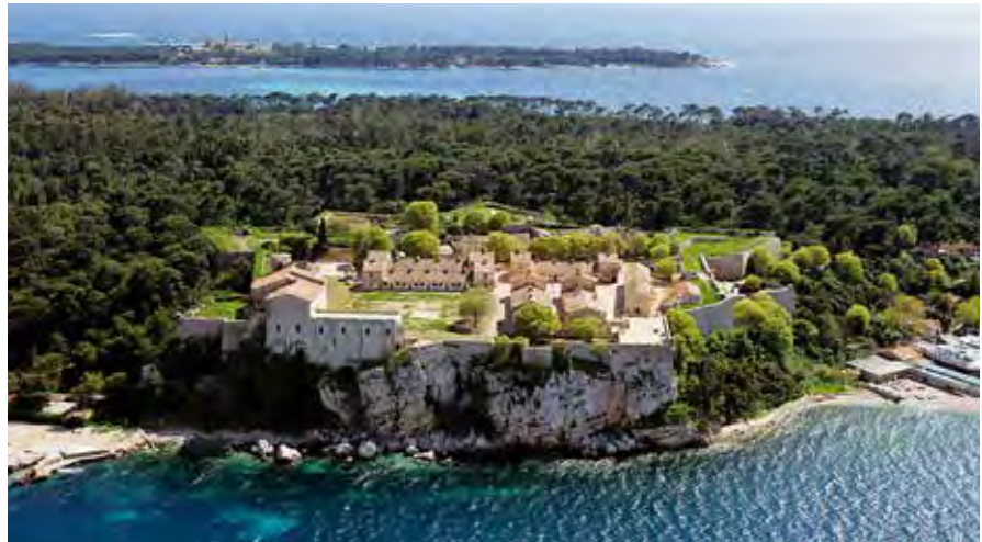
Casernes de la période Vauban au fort Royal de Sainte-Marguerite (Cannes), vers 1700 © DR
