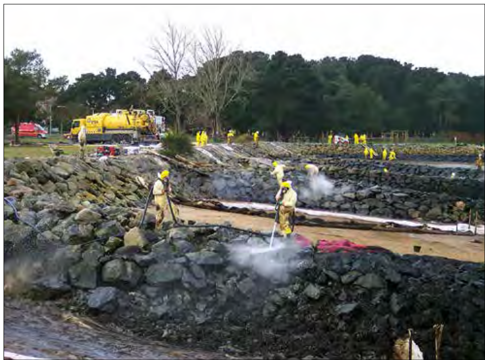
Nettoyage d'énrochements © DR
