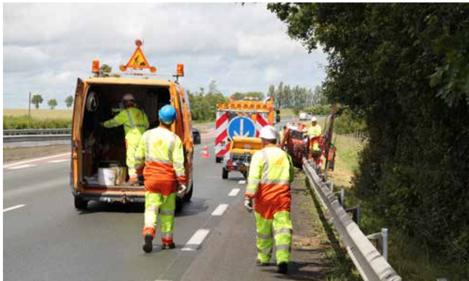
Travaux ©DIR Ouest
