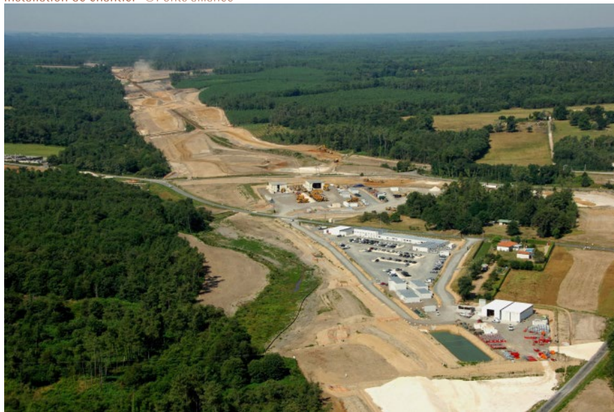
Installation de chantier ©Ponts alliance
