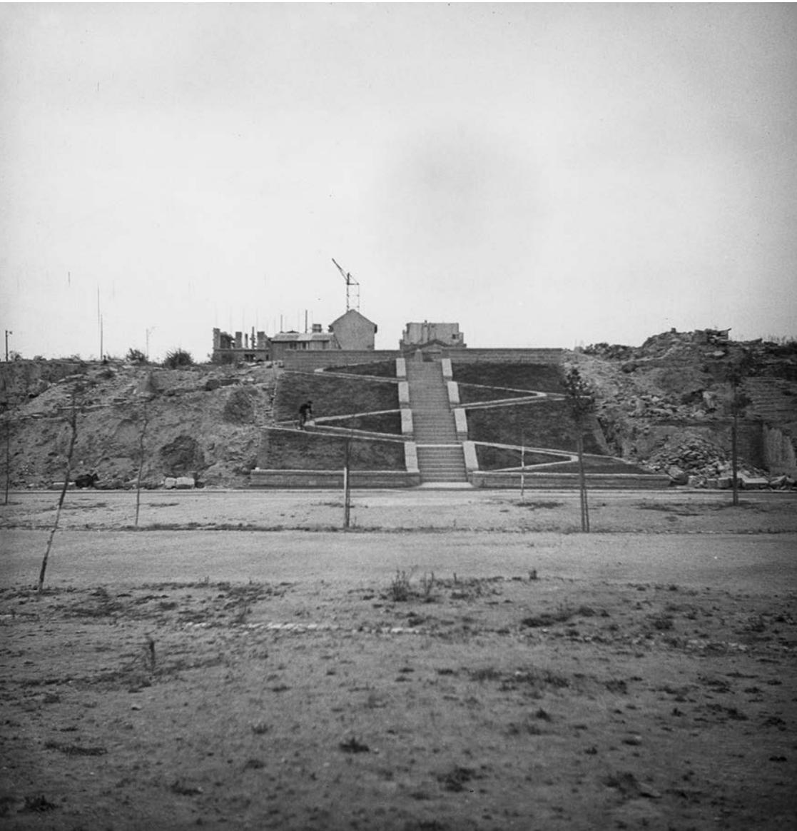
Le centre de Brest est reconstruit sur les gravats remblayés. Le relief originel, très escarpé et vallonné, est profondément remodelé et adouci. Certains escaliers disparaissent du fait du nivellement et d'autres sont créés, comme celui-ci qui est aujourd'hui à l'angle des rues de l'Aiguillon et de Denver.
