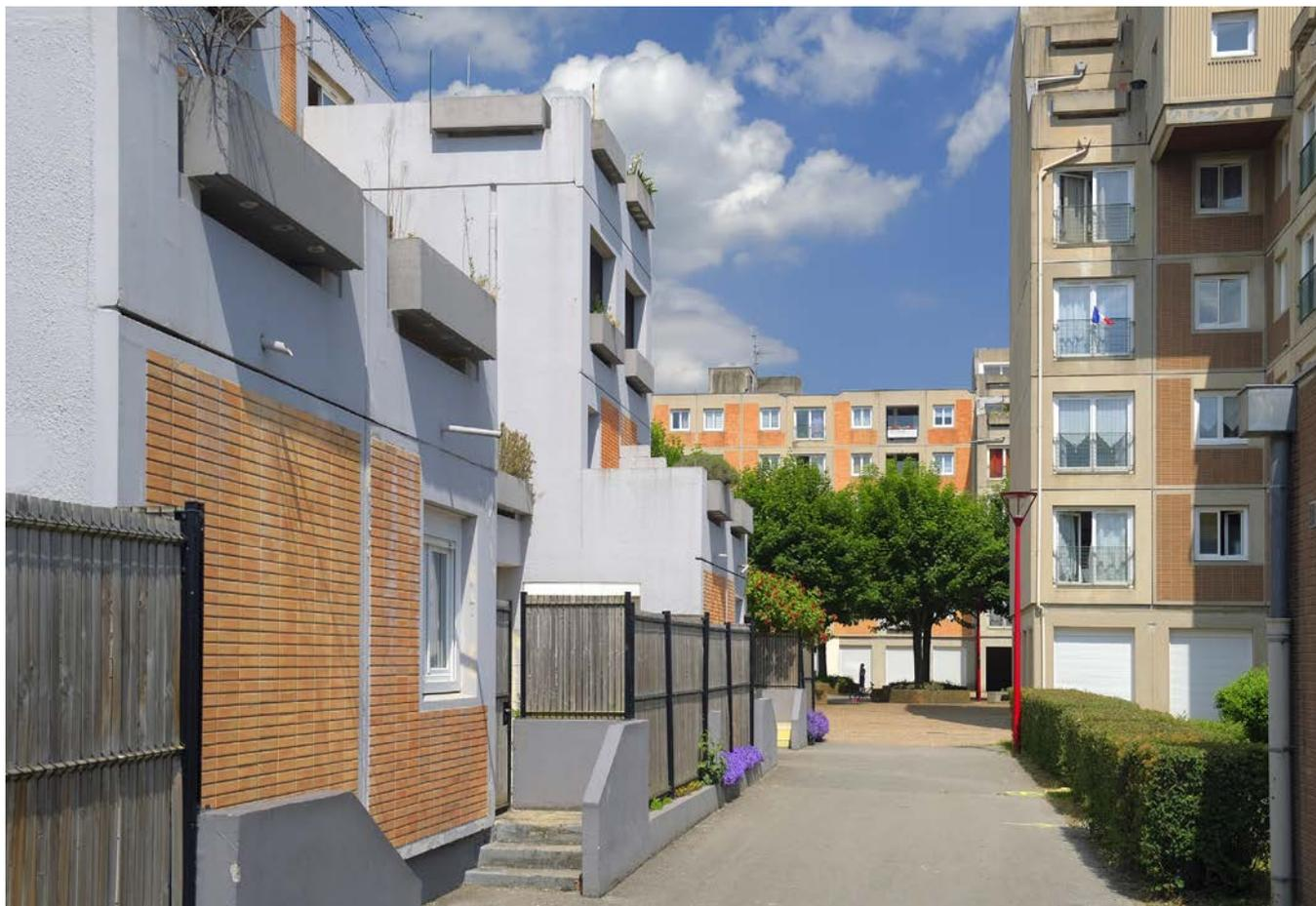
Figure 2. Modèle innovation Maille à Arques, Cofeba (Jean Baretts), Georges Loiseau & Jean Tribel architectes. Le modèle Maille est constitué de pièces préfabriquées assemblées comme un meccano selon une maille dimensionnelle de 90 cm de côté, dont la qualité de mise en œuvre est exceptionnelle dans cette opération aujourd'hui inscrite au titre des Monuments Historiques. Photographie © Lacth-Vincent Lecigne 2020
