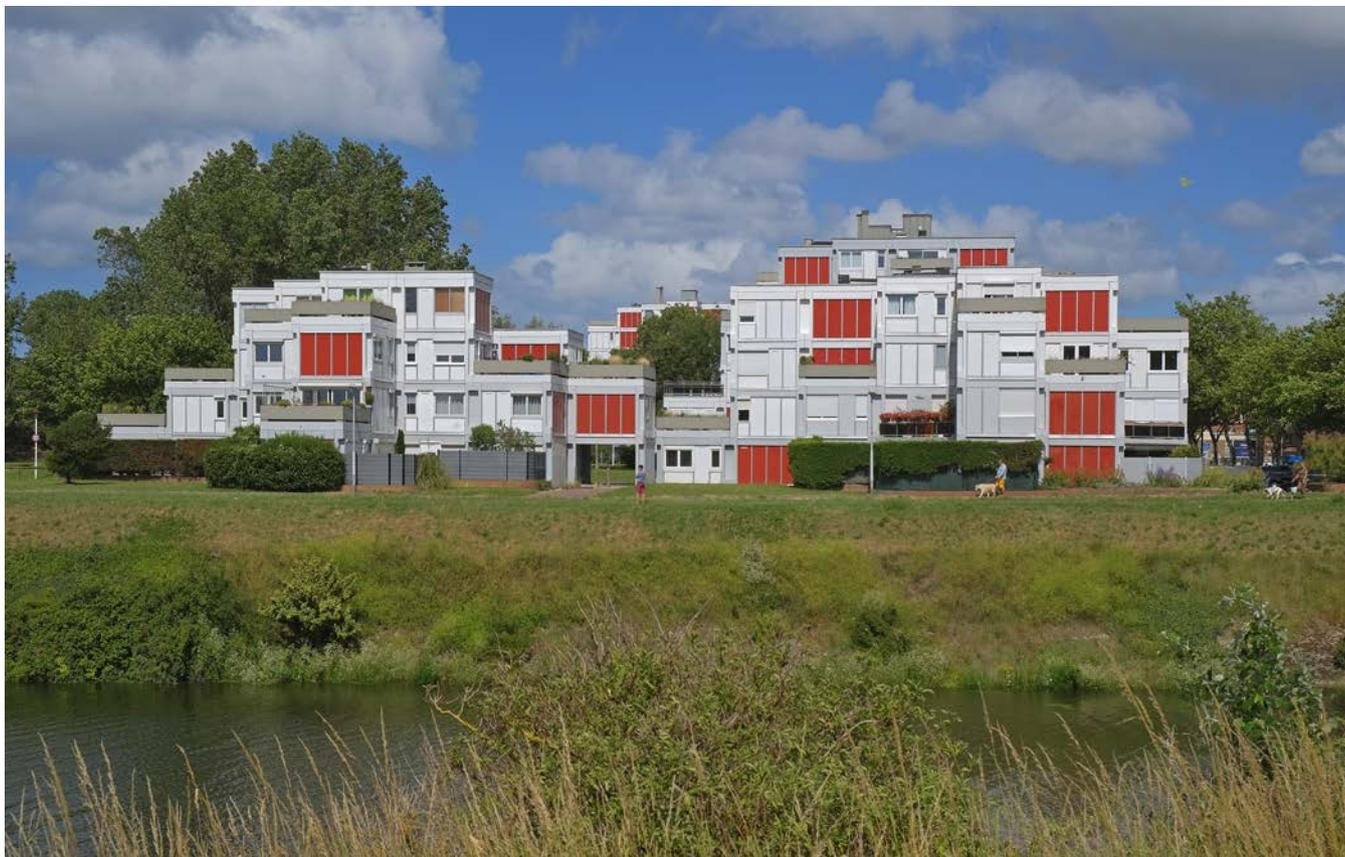
Figure 1. Modèle innovation Maillard-SAE à Dunkerque, Henri-Pierre Maillard architecte. Le modèle Maillard repose sur le principe d'un tabouret structurel composé de quatre poteaux, quatre poutres et une prédalle produisant des immeubles polycubiques, reconnaissables au traitement de l'angle rentrant de leur structure verticale. Photographie © Lacth-Vincent Lecigne 2020
