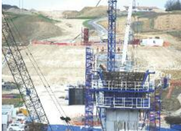
# LGV SUD-EUROPE-ATLANTIQUE : POSE DES PREMIERS VOUSOIRS AU VIADUC DE LA BOËME
