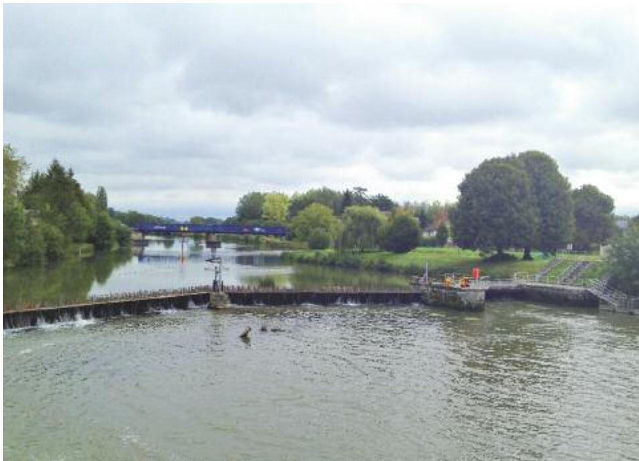
# RECONSTRUCTION DES BARRAGES MANUELS DE L'AINSE
