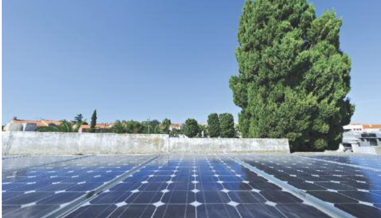
# INSTALLATION D'ÉNERGIE COMPENSÉE POUR L'ILLUMINATION DE LA CHAPELLE SAINT-JULIEN À VILLENEUVE-DE-LA-RAHO
