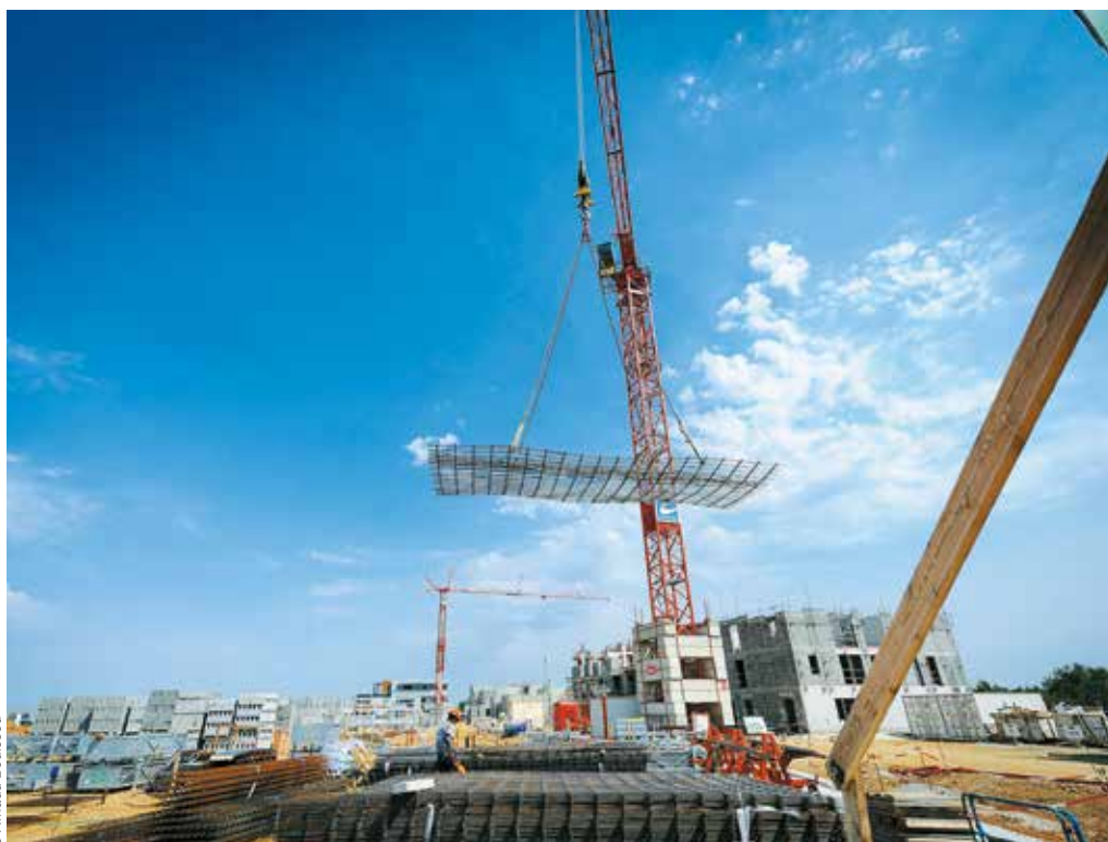
Le chantier de l'éco-quartier des Montgorges en construction, à Poitiers (86). Comme tous les documents d'urbanisme, le plan d'occupation des sols relève de la responsabilité des missions régionales de l'Ae.
