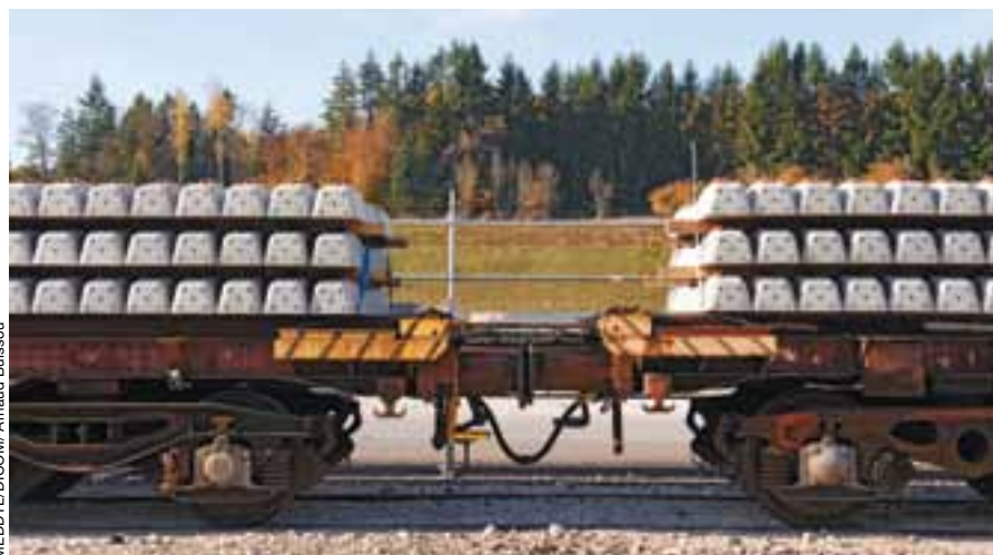
Construction du TGV Rhin-Rhône.
