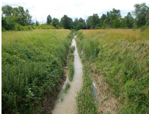
FIGURE 4 : ASPECT DU COURS D'EAU ARTIFICIEL
