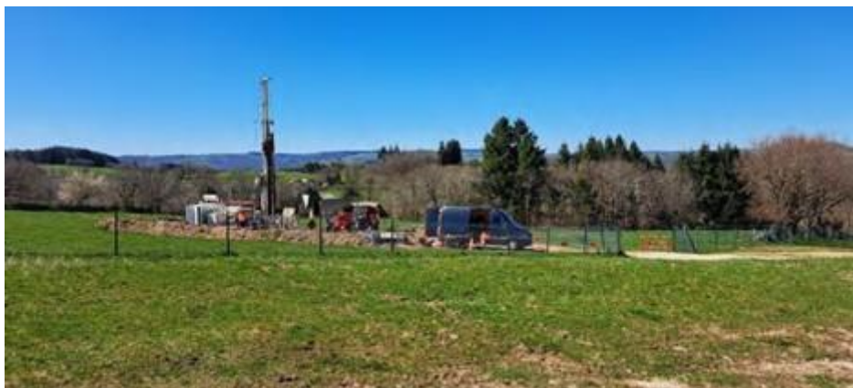
Figure 5 : exemple d'une plateforme de forage (source : dossier)
