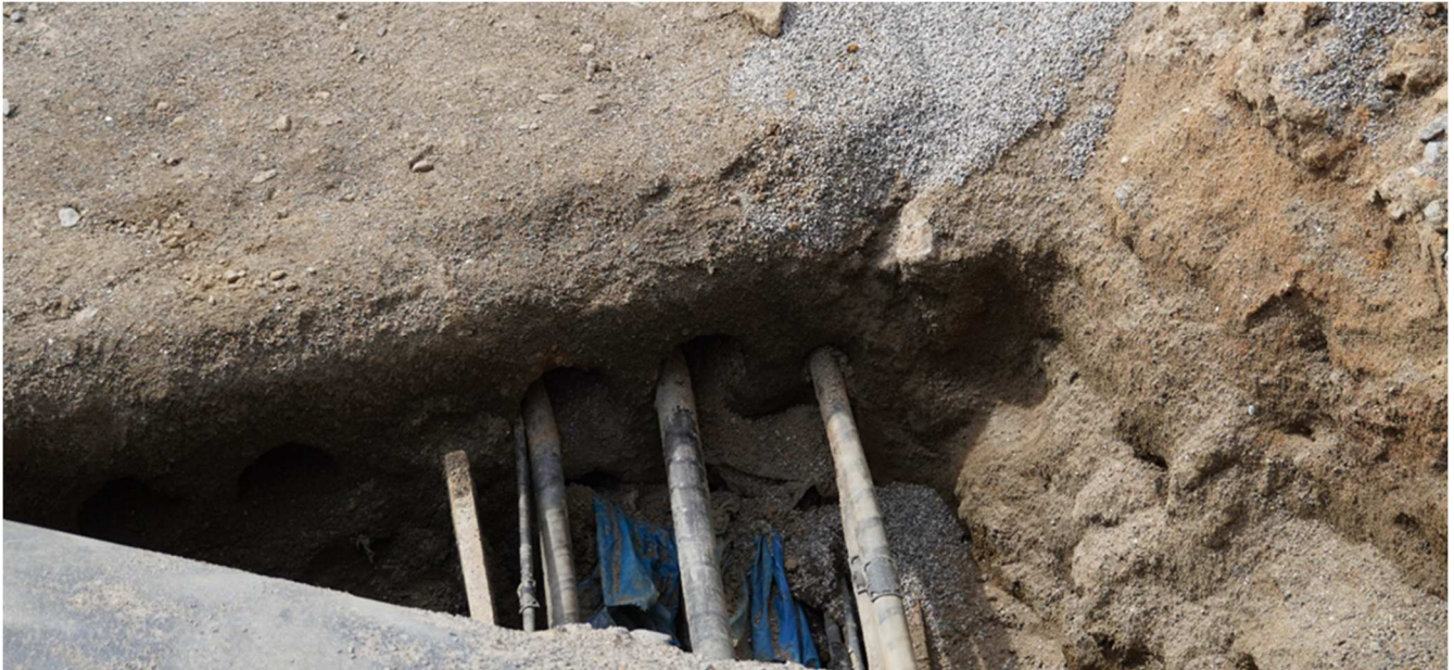
Figure 5 : gaine en béton protégeant les câbles
