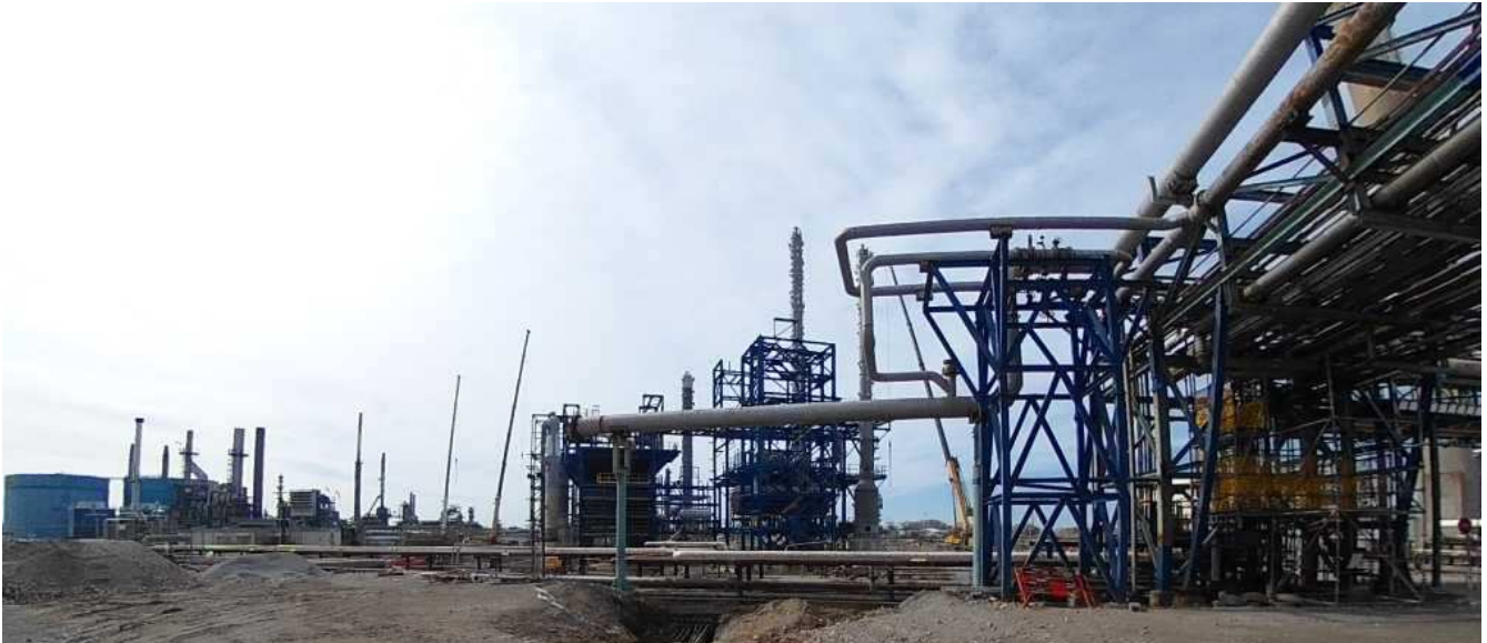
Figure 1 : travaux en cours sur la plate-forme
