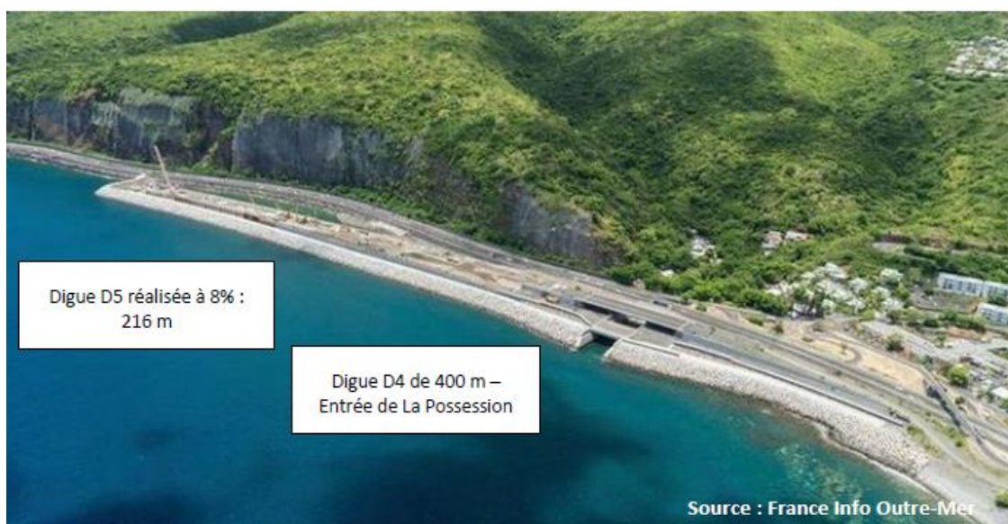
Figure 4 : Les ouvrages déjà réalisés du côté de La Possession (source : dossier).
