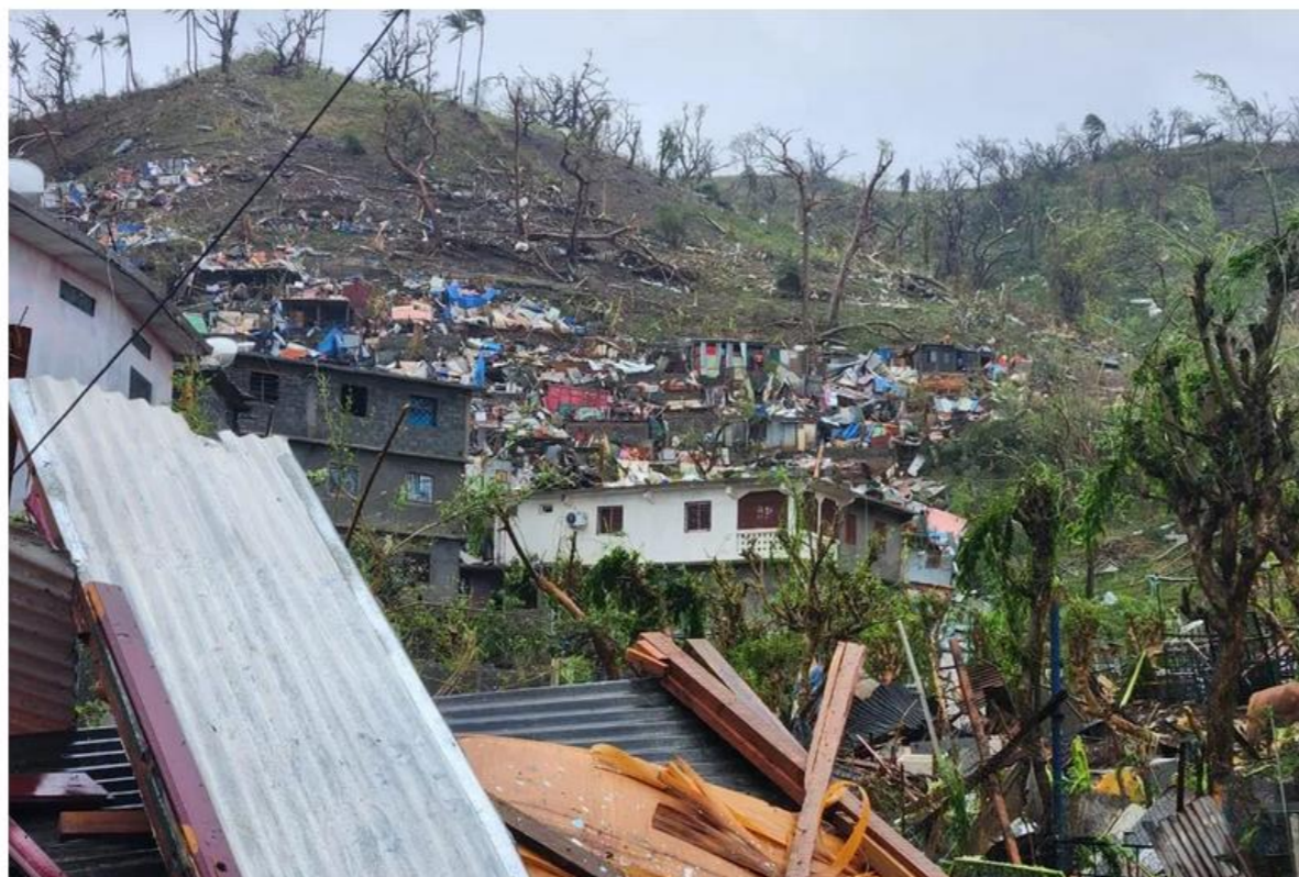
Les dégâts dans les bidonvilles de Kawéni après le passage du cyclone Chido • ©Mayotte la 1ère |
