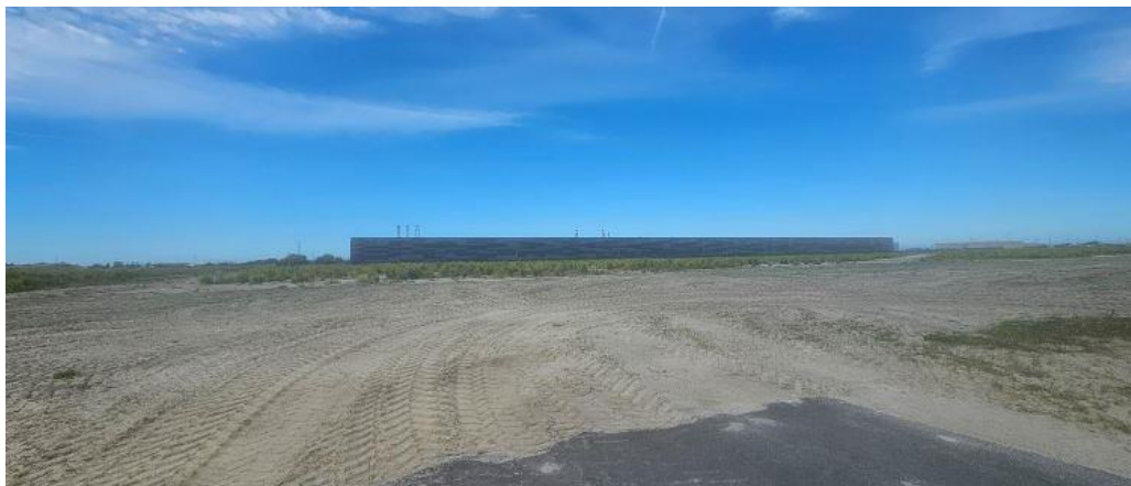
Figure 2 : vue de la zone DLI Sud après remblaiement (source: dossier)
