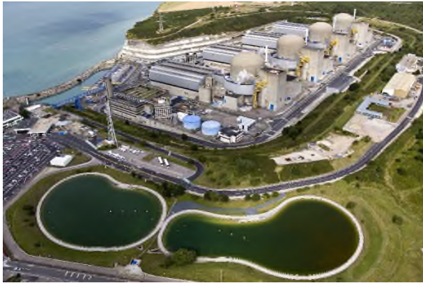
Figure 2 : Vue générale du centre nucléaire de production d'électricité de Paluel – Source : dossier
