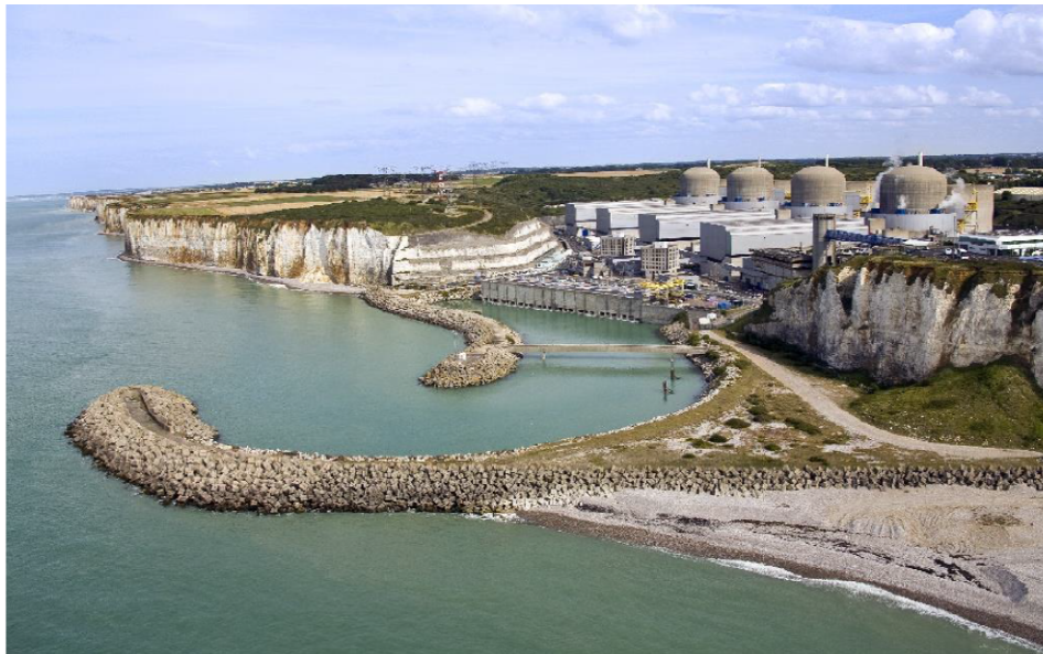
Figure 6 : Canal d'amenée du CNPE de Paluel – Source : dossier
