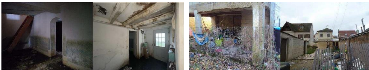
Figure 4 : Photographies d'habitations dégradées dans le quartier Belleplace-Blandin (Source : dossier)
