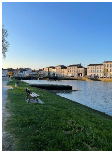
Figure 2 : Écluse de Ribérou sur la commune de Saujon. Source : rapporteurs
