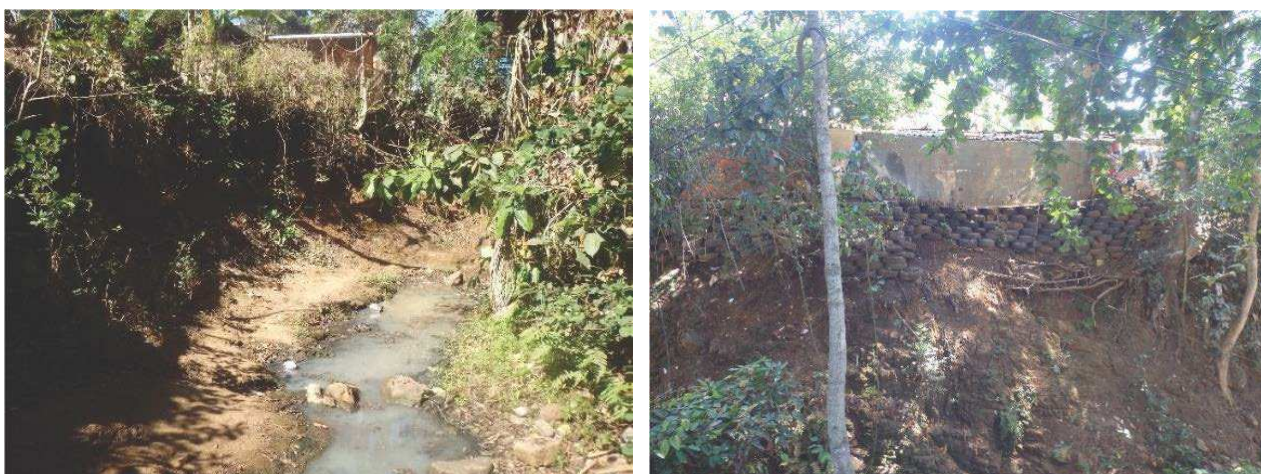
Figure 7 – Phénomènes érosifs sur la partie médiane de la rivière et talus stabilisés au moyen de pneus (source : dossier)
