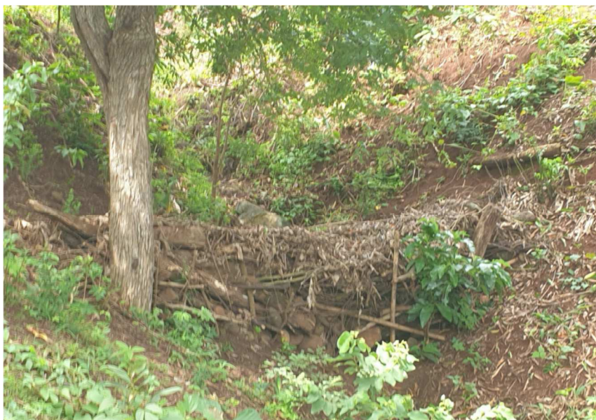
Figure 2 : barrage en fascines protégeant un talweg de son ravinement (source : rapporteurs)
