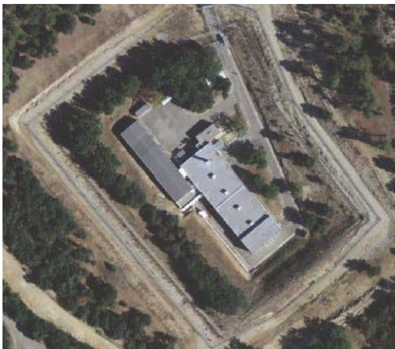
Figure 4 : Vue aérienne de l'INB 53 (Source : dossier).
