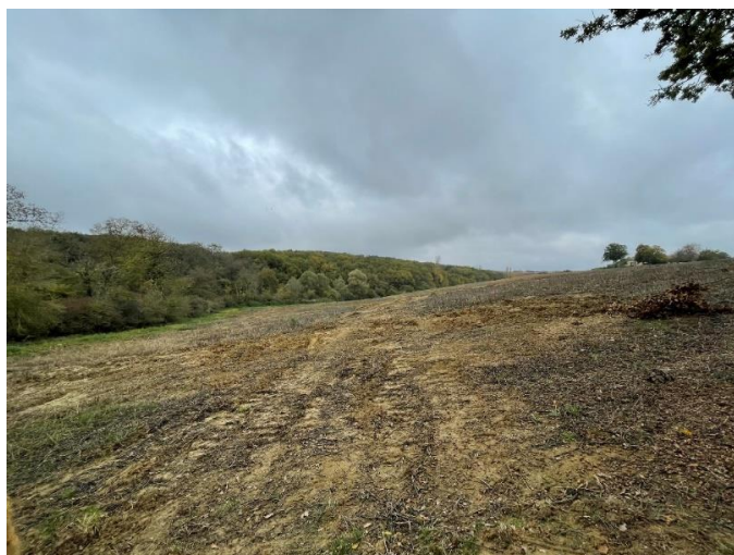
Figure 6 : Secteur de Bois Haucourt, comportant un fort dénivelé et impliquant un remblai et des passages toute faune (Source : rapporteurs)
