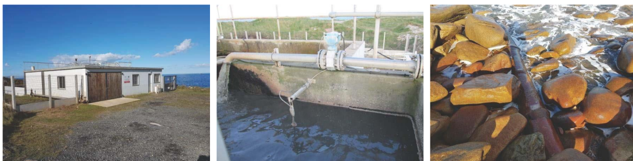
Figure 4 : Vue générale de la station, dégraisseur (au centre), et émissaire de rejet en mer
