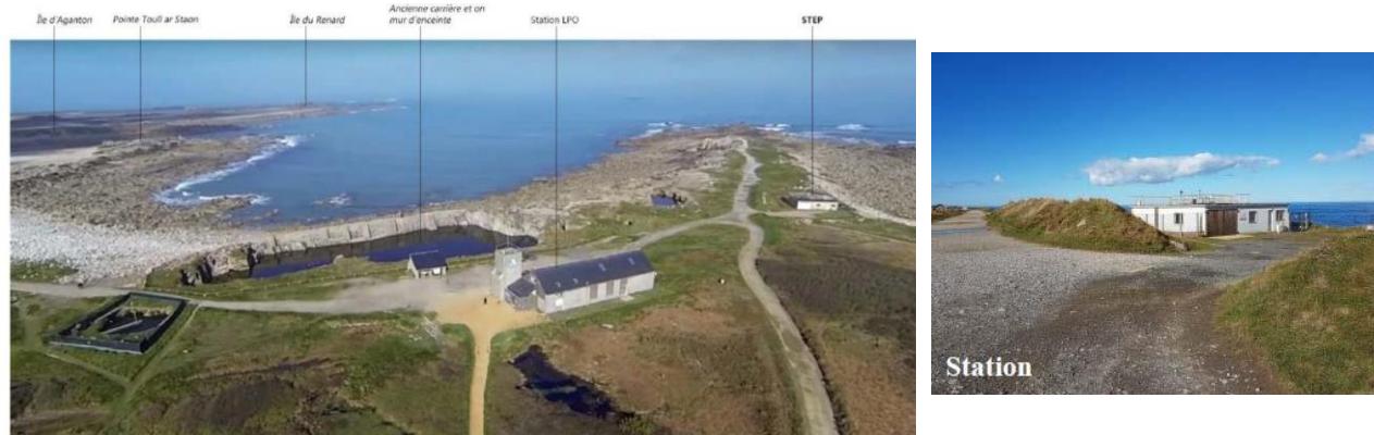
Figure 2 : Vues du site de Kastel-Ereik et de la station d'épuration actuelle (Source : dossier)
