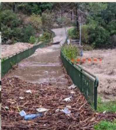
Pont de CHAMBOREDON (30) 3 oct 2021
